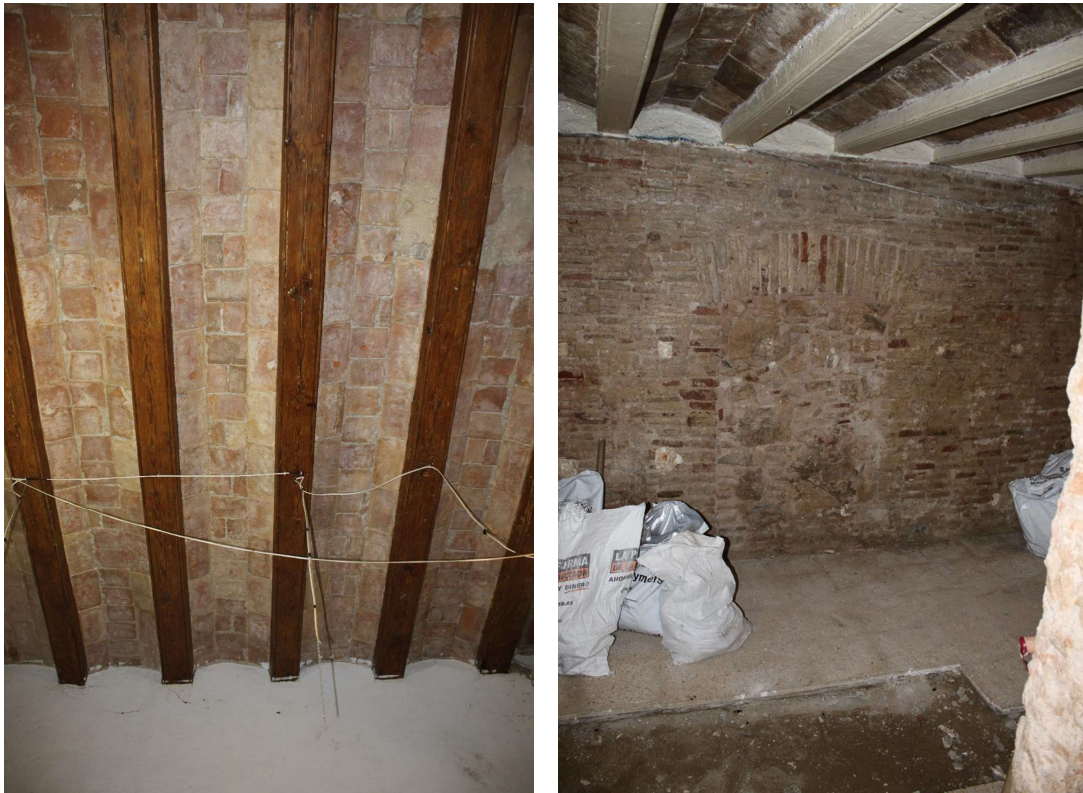
Esquerra vista del sostre fet amb revoltos. Dreta porta tapiada en el mur divisor (PLI. Artigues. 2020)
