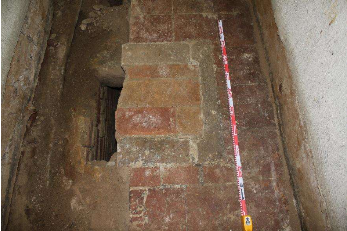
Trapa del col·lector amb restes de la seva tapadora. (PLI. Artigues. 2020)
