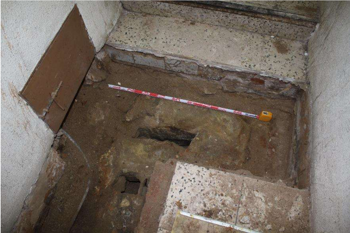
Vista en planta de part de la coberta del col·lector També es pot observar el graó que havia quedat ocult pel canvi de cota del paviment i l'acabat amb rajola blanca del seu davant (PL. Artigues 2020)
