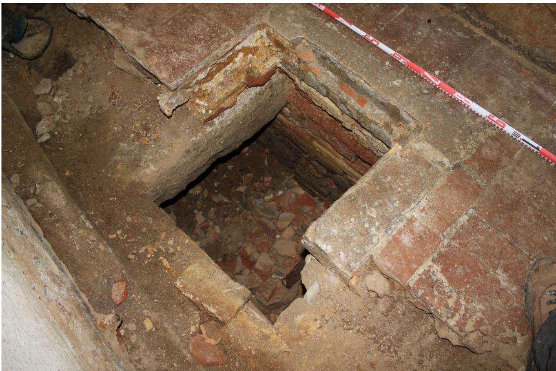
Vista de la trapa sense tapadora i de l'interior del col·lector. (PLI. Artigues 2020)
