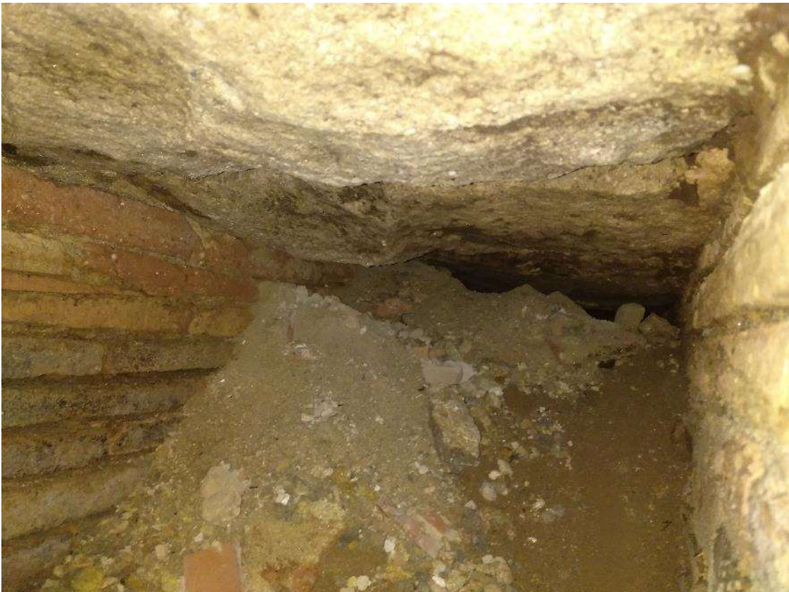
Interior del col·lector completament reblert per runa. (PLI. Artigues 2020)
