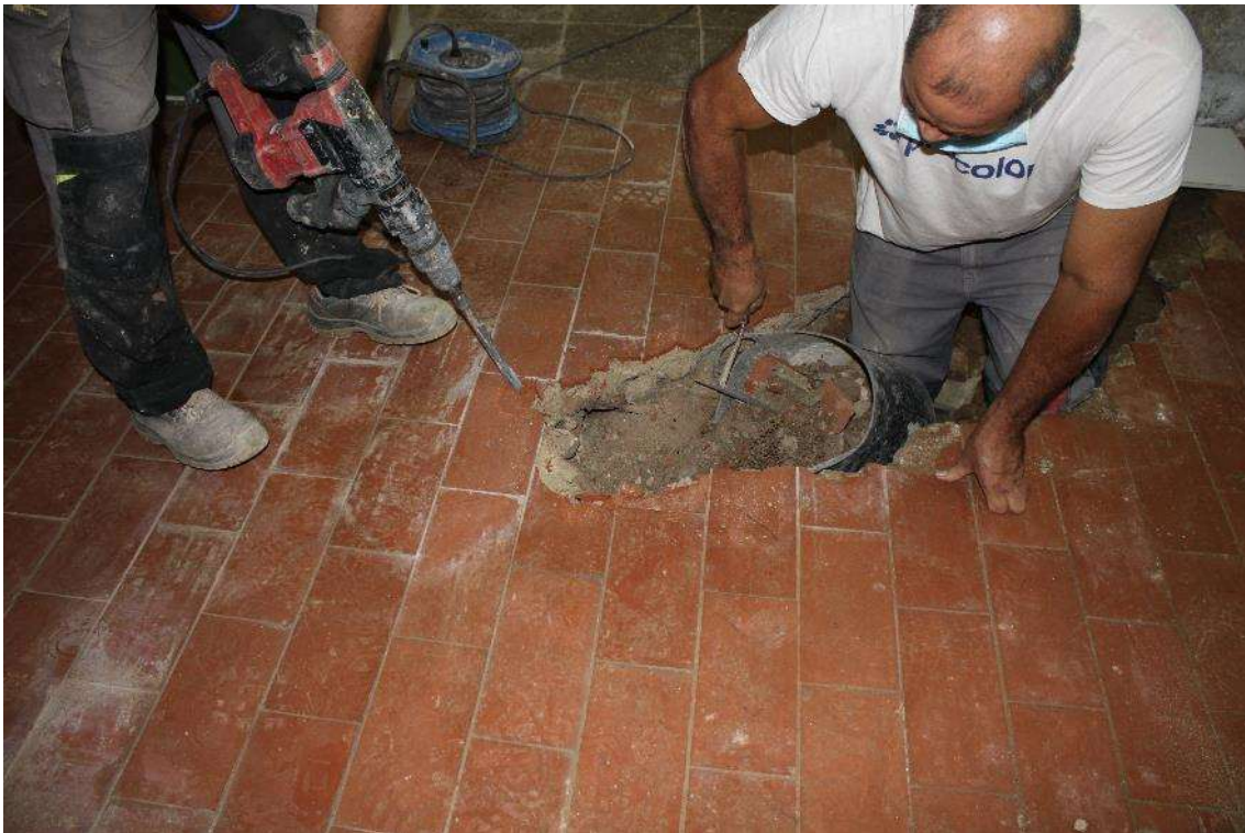
Procés d'excavació amb mitjans mecànics i manuals de la rasa4 (PL. Artigues 2020).
